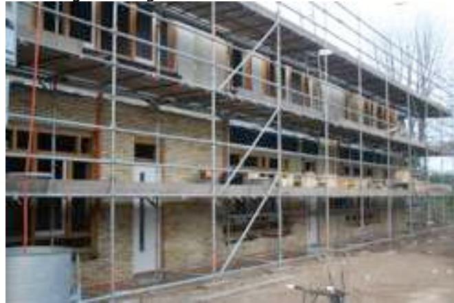
Boven hangen nu ook de meeste kozijnen en het metselen op hoogte is begonnen.
