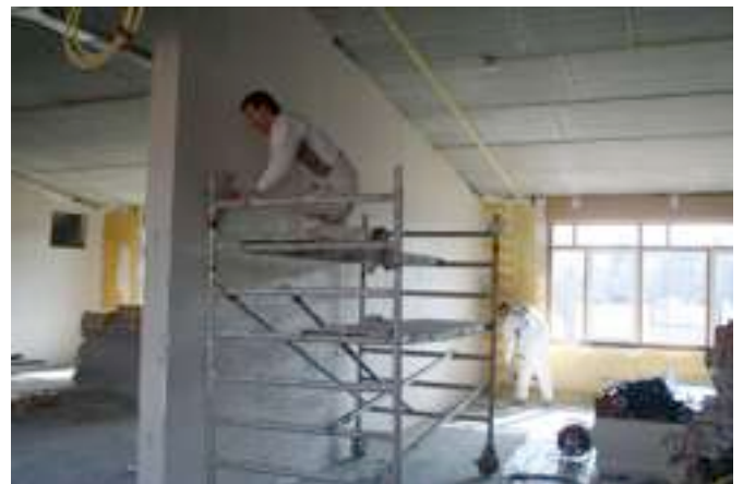
Stucadoors aan het werk
