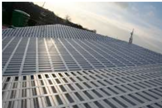
Het kanaaldak... vanaf de steiger, mooie ritmiek ©
