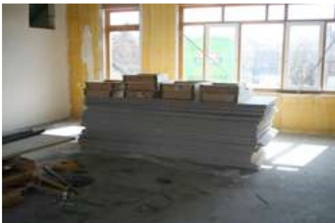
Gipsplaten worden naar binnen gebracht.
