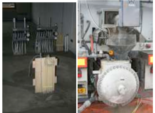
De foto van vorige week, maar nu met gestorte cementdekvloer (links) en de achterkant van de vrachtauto met alle ruwe materialen voor cementdekvloeren die achter op de auto worden gemengd en de school ingepompt via de leiding onder. Het grote ronde ding is de mixer en pomp.
