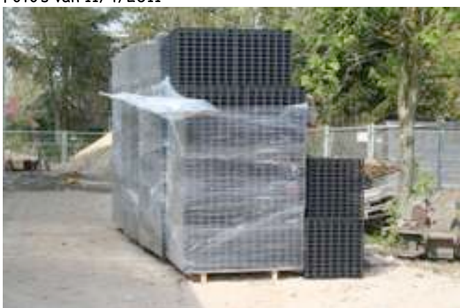
Deze plastic 'kratten' gaan in de grond om het hemelwater van het dak van de school snel in de grond te krijgen. Het hemelwater gaat NIET het riool in.
