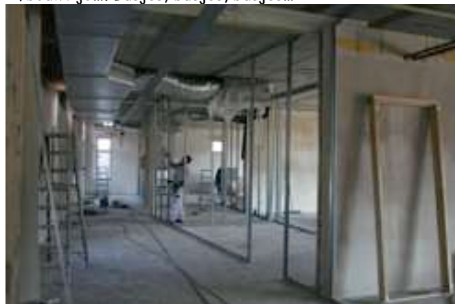
Metalen frames plaatsen
