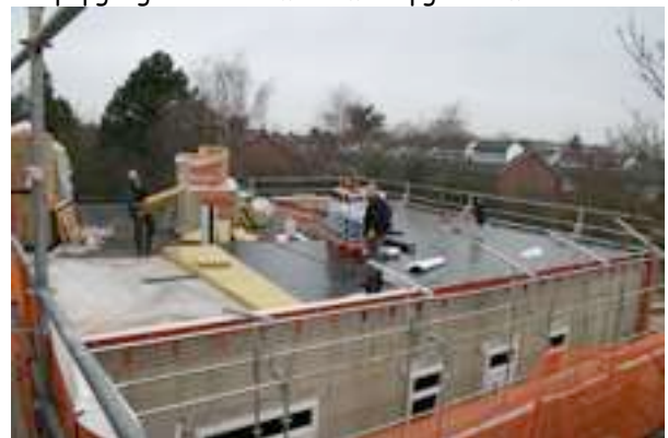
Trapopgang en buitenmuur met opgaand metselwerk
