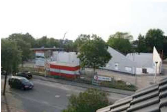
Overzicht van de bouwplaats 24/06
