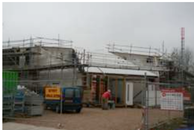
Een deel van het basisdak van de grote zaal ligt ook al. De andere delen komen wanneer steunbalken zijn aangebracht.
