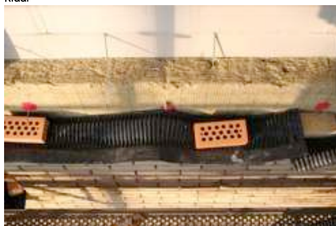
Zicht van boven op een deelgemetselde muur. Duidelijk zichtbaar zijn van achter naar voor:
