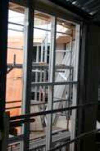
De grote zaal en de pui van de trapopgangen
