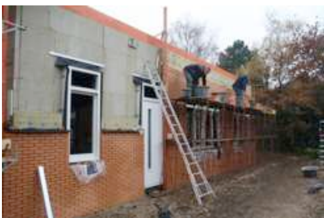
Het eerste metselwerk op de steiger was afgelopen maandag 08/11 te zien bij de BSO. Hier geen hoge steiger omdat het maar 1 verdieping metselen is.
