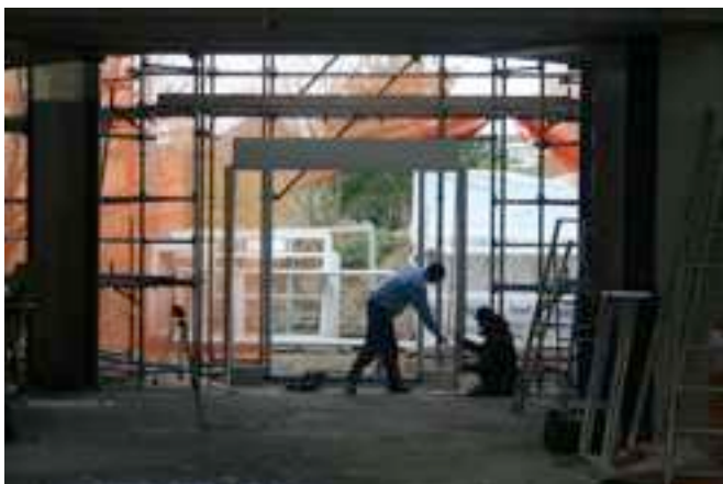
Het stellen van de 'voor deur'. Mooie hardhouten kozijnen met DTS vloerdelen (sterk!)
