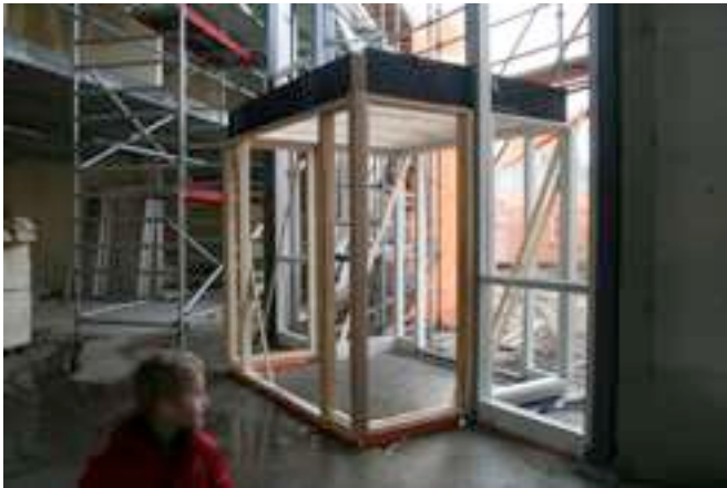
Het portaal van de school in ruwbouw klaar
