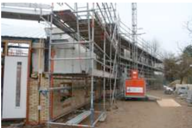
De andere steigers zijn twee verdiepingen hoog en degelijke bouwconstructies.
