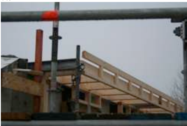
Overstek basisconstructie
