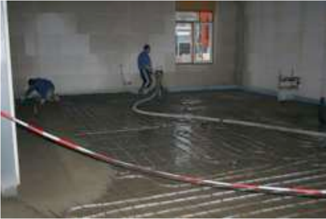
Binnenin is men al een aantal dagen bezig met cementdekvloeren over de vloerverwarming heen. Hier zijn de mensen beneden bezig. Goed te zien: eerst bouwvloer, daarop vloerverwarming, dan netje en dat allemaal ingebed in cement.
