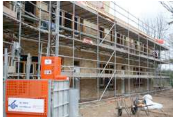
Zijmuur Cornelia de Langelaan, metselwerk bijna boven.
