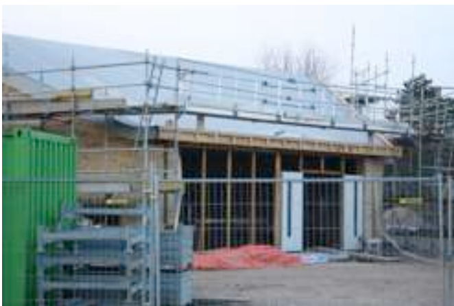
Foto 1: het dak van de nieuwbouw is dicht... de dakdekker had nog wel wat klusjes maar het grootste deel van het werk is klaar.
