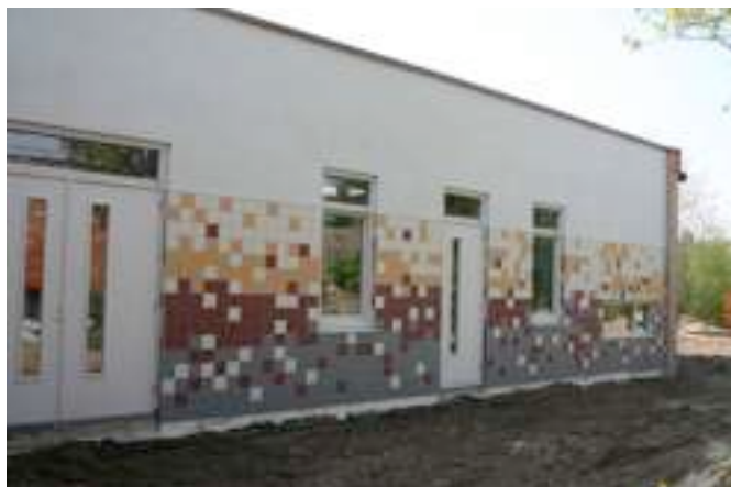
Op het binnenplein is de eerste muur vrij van steigerwerk. Tegels tot bovenkant deur en daarboven schoon stucwerk.
