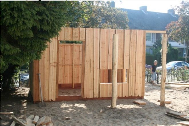
Na een zaterdag klussen is het kleuterspeelhuis annex berghok een stuk opgeschoten
