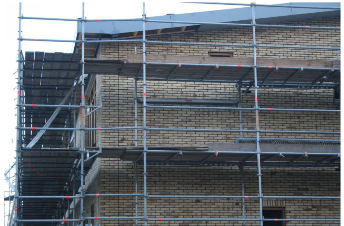
Foto 4: Moeilijk te zien, maar deze muur is geheel gevoegd, de afwerking van de overstek wordt nu gedaan.
