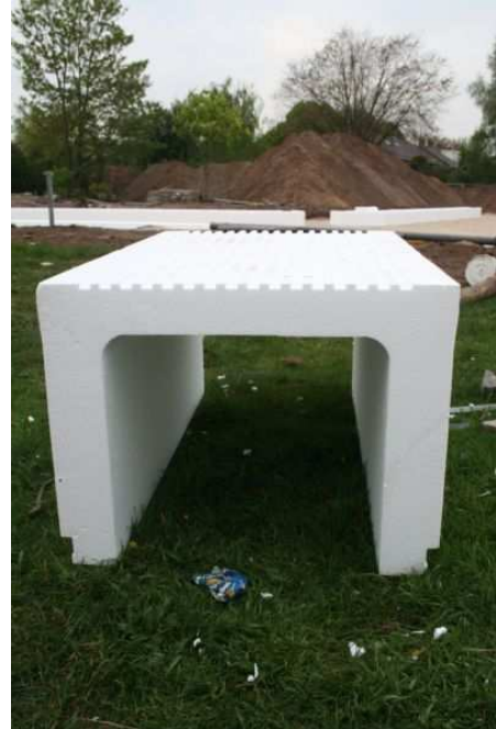
Piepschuim betonbak op z'n kop
